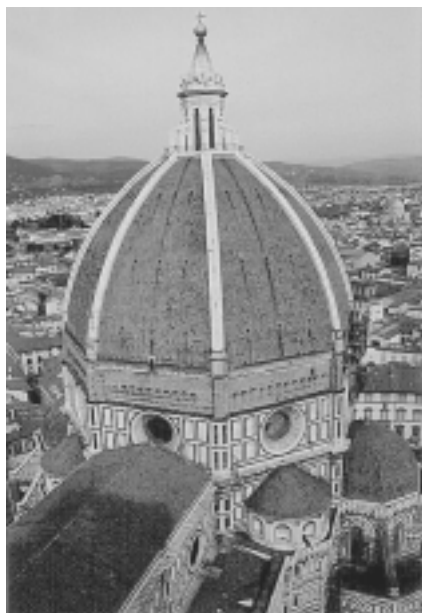
La cúpula de Brunelleschi en la iglesia de Santa María de Fiore en Florencia, Italia, se construyó entre 1420 y 1426. Brunelleschi se valió del principio de acción mínima de la catenaria como una guía para establecer la curvatura de los ladrillos y para estabilizar la estructura.
